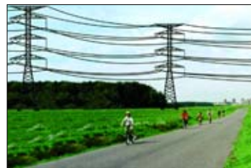
Rekreantům z Jižního Města je přichystán tento odpudivý výhled. Křeslice žádají umístit alespoň vedení 2x 110 kV v kabelech do země. Snížila by se výška sloupů i počet vodičů
